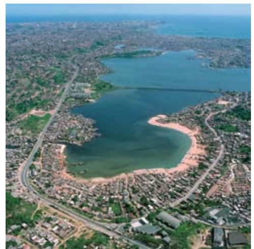
1998. Durante a intervenção: palafitas removidas e início da recuperação ambiental
